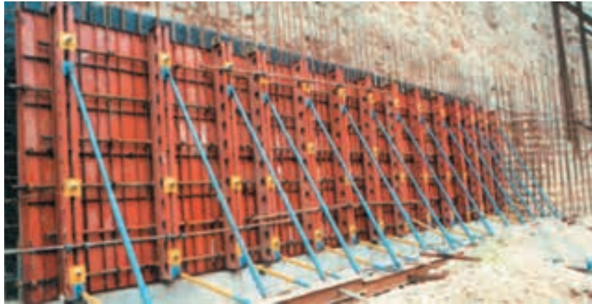
شکل ۷-۲۱- مهار قالب دیوار به وسیله جک های شاغول کننده
