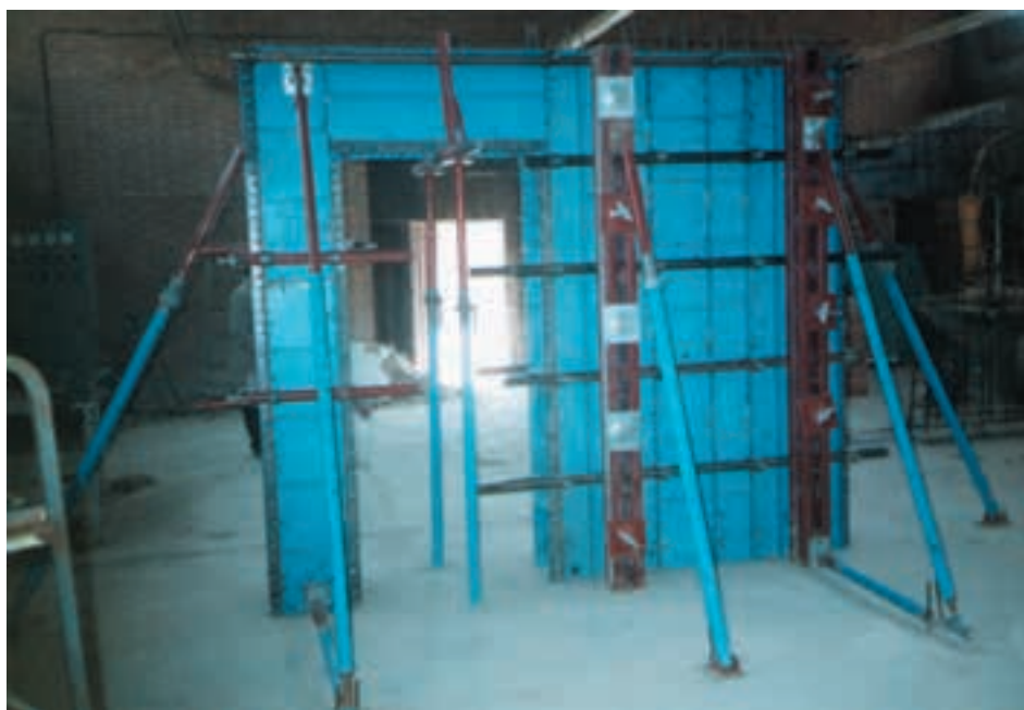
شکل ۲۹-۸ - قالب تکمیل شده دیوار و ستون بتنی
