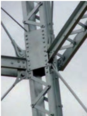
شکل ۳-۱ کاربرد پیچ اتصال
