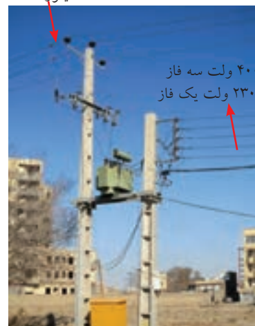
شکل ۱-۷ تبدیل ولتاژ ۲۰ کیلوولت به ۴۰۰ و ۲۳۰ ولت.
