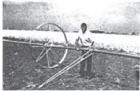
الف) نصب جک تثبیت روی لوله‌ها
