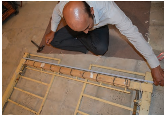
شکل ۱۶-۵ - نصب چوب پایین کشی پشت زیردار
