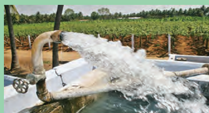
شکل ۱۶- لوله برگشت آب
