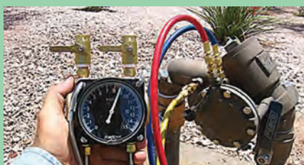
شکل ۱۷- تنظیم فشار شیر فشارشکن
