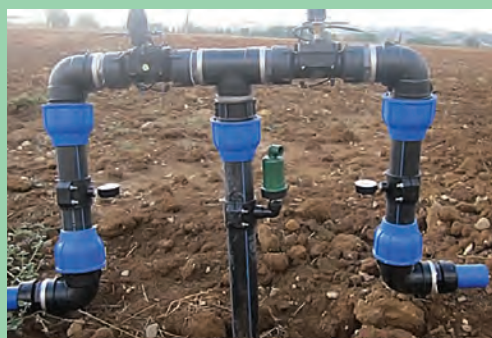
شکل ۱۸- شیر و فشارسنج روی بال ها
