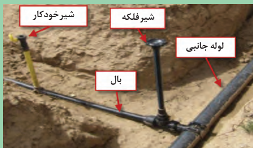
شکل ۱۱- محل شیر فلکه روی بال
