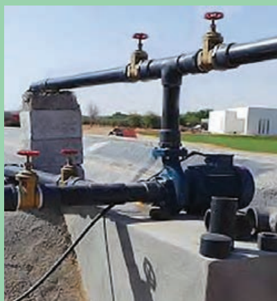
شکل ۱۰- شیر فلکه لوله رانش
