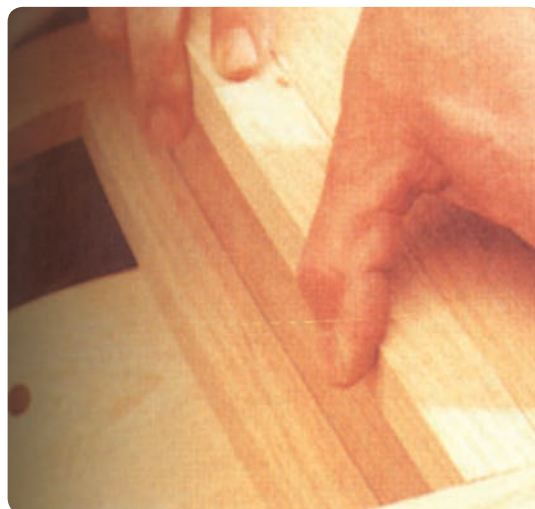
شکل ۶-۱۵۶ نصب ریل هدایت کشو
