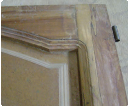
شکل ۶-۸۹ ابزار زدن قاب و تنکه
