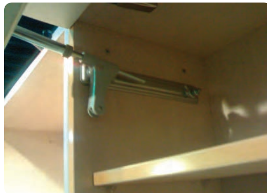
شکل ۶-۳۷ در کابینت نصب شده با نگه‌دارنده پمپی
