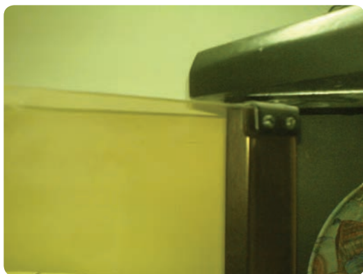
شکل ۶-۴۰ در شیشه‌ای با لولای پاشنه‌ای
