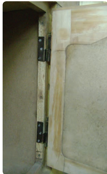
شکل ۶-۸۸ در قاب تنکه‌ای با لولای قابل‌مهم‌ای
