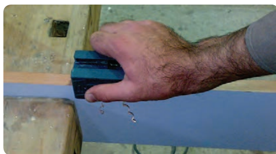
شکل ۶-۸۲ پرداخت لبه اضافی روکش
