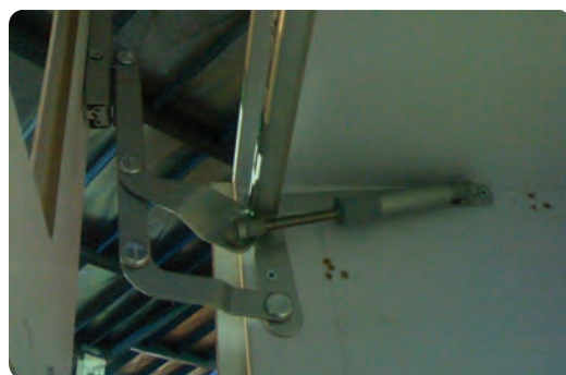
شکل ۶-۳۸ در کابینت نصب شده با جک اتوبوسی
