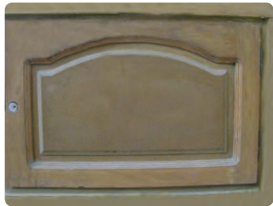
شکل ۶-۸۷ در قاب و تنکه‌ای کابینت
