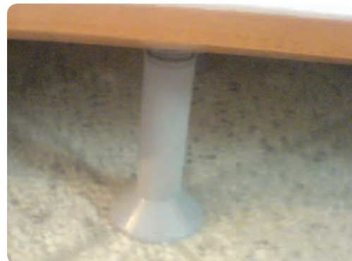
شکل ۶-۶۴ پایه نصب شده در زیر کابینت
