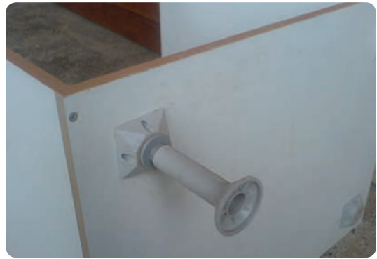
شکل ۱۱۵-۶ پایه نصب شده زیر کابینت
