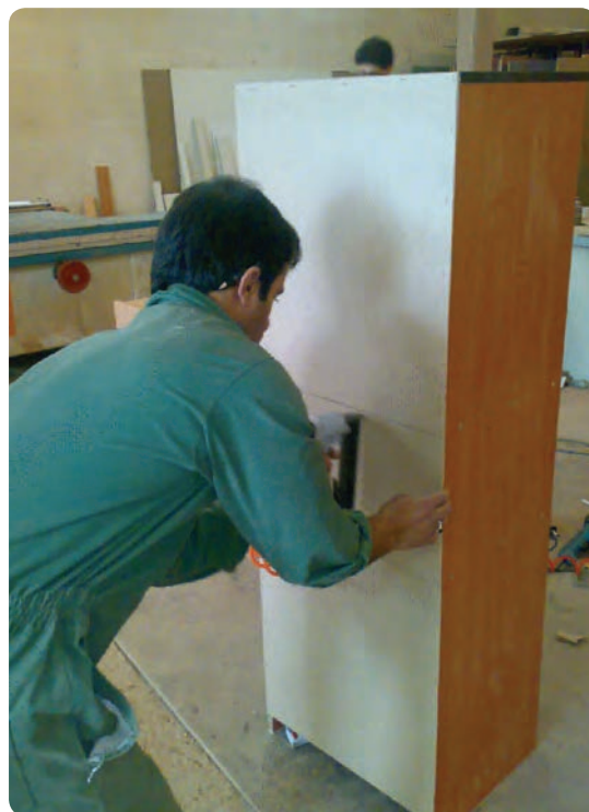
شکل ۱۲۱-۶ نصب پشت بند کابینت
