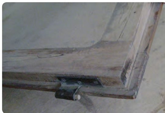
شکل ۹۱-۶ نصب لولای قابلمه‌ای در دو راهه در
