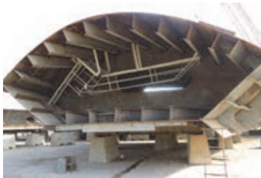
شکل ۶- اتمام جوش کاری بلوک کشتی
