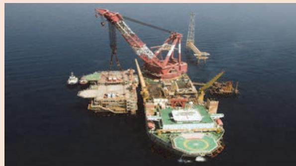
عملیات نصب سکوی فاز ۱۹ پارس جنوبی در خلیج همیشگی فارس با به کارگیری از یکی از مدرن‌ترین شناورهای نصب منطقه (اوشنیک ۵۰۰۰)
