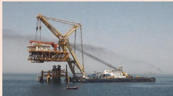
عملیات نصب سکوی فرآورش لایه نفتی پارس جنوبی به وسیله شناور جرثقیل دار صد ۳۰۰۰
