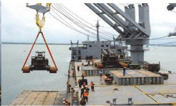
شکل ۵-۱۲- تخلیه و بارگیری کالا با استفاده از جرثقیل کشتی
