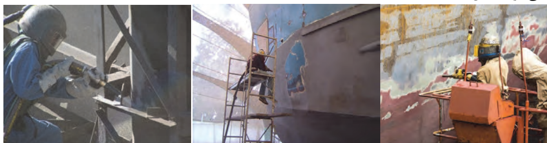
شکل ۱-۷ زنگ‌زدایی در اسکله خشک
