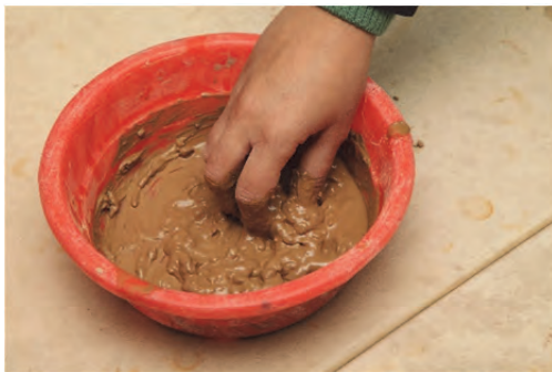
شکل ۱۰- تهیهٔ گل یکنواخت با دوغاب
