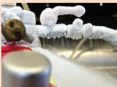
شکل ۱۲-۵- شیر و اتصالات یخ زده
