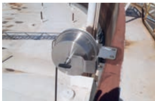
شکل ۴-۲۶- تخلیه الکتریسیته ساکن در مخزن سقف شناور
