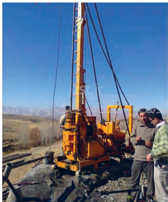
دستگاه حفاری مستقر شده بر روی فونداسیون
