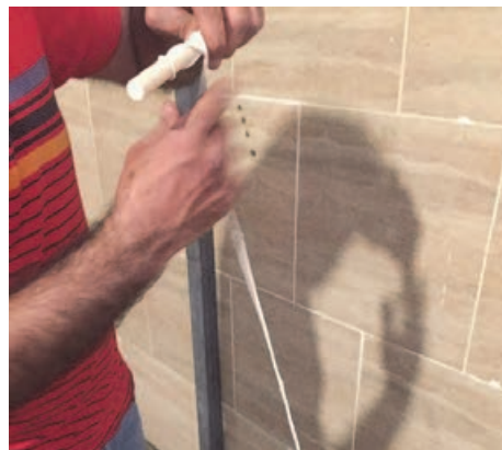
شکل ۶۷- پیچیدن نخ ها روی چوب ماسوره
