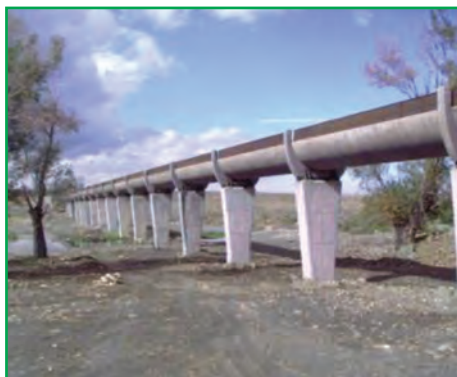
شکل ۱-۴۵- کانال انتقال آب (سیاه کمر)
