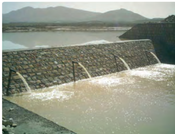
شکل ۳۰-۱ سد رسوب‌گیر (قیر و کارزین)
