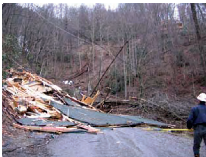
شکل ۱۲-۱- تخریب ناشی از رانش زمین
