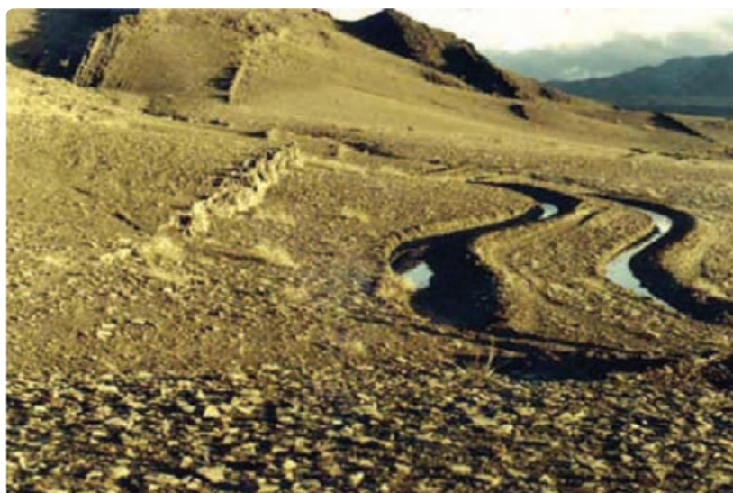
شکل ۳۲-۱- احداث بانکت جهت حفاظت خاک (منطقه فسا)
