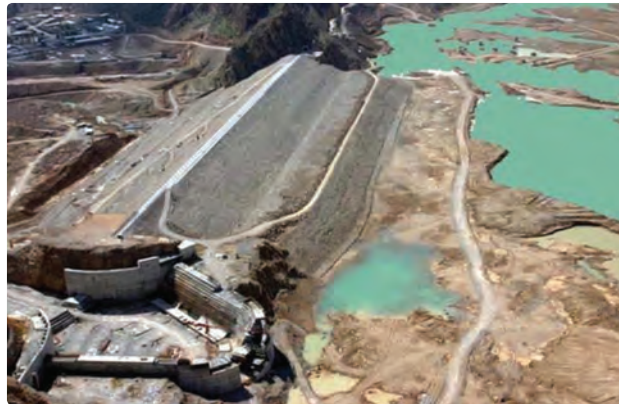
شکل ۱-۲۵- احداث سد سیوند بر روی رود سیوند
