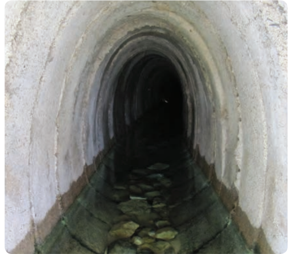
شکل ۸-۴- قنات شیوه سنتی بهره‌برداری از آب زیرزمینی (میله و کوره قنات)
