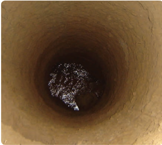
شکل ۸-۴- قنات شیوه سنتی بهره‌برداری از آب زیرزمینی (میله و کوره قنات)
