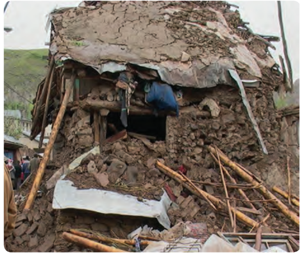
شکل ۲-۵- زلزله سال ۱۳۸۳- طالقان
