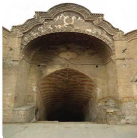
شکل ۱۳-۱ ورودی آب انبار، بنایی برای ذخیره آب در قدیم - شهر سمنان
