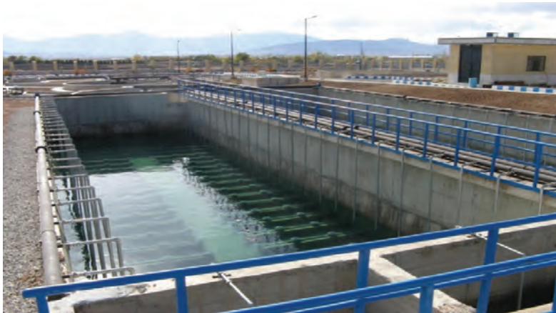
تصویر ۱-۵- تصفیه خانه شهرک صنعتی شهرکرد
