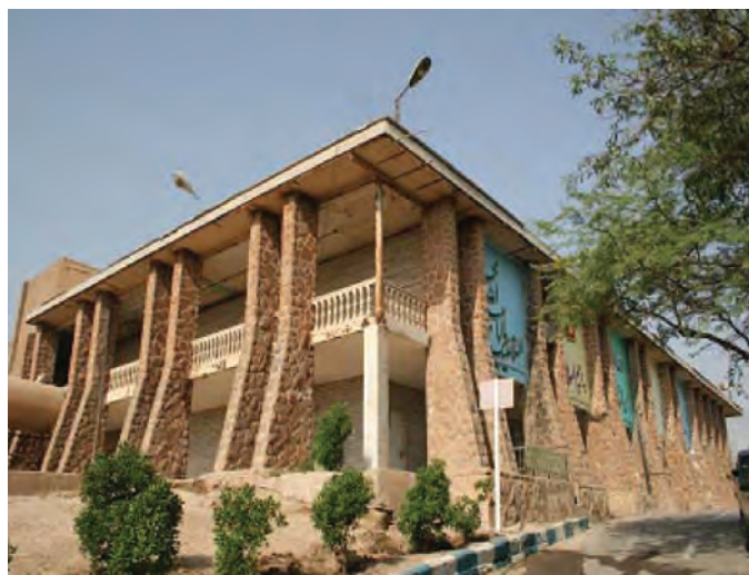
شکل ۳۰-۴. ساختمان گلف در اهواز
