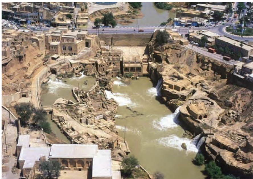
شکل ۱۴-۵- سازه‌های آبی شوستر
