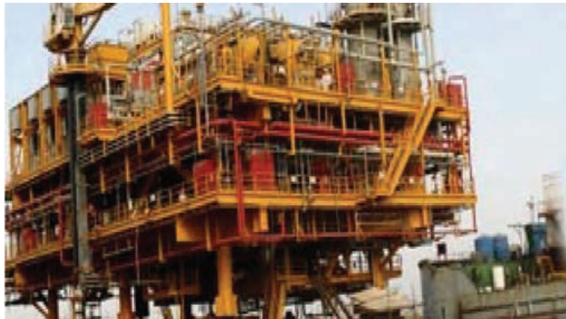
شکل ۳۷-۵- ساخت سازه و سکوهای دریایی در خرمشهر
