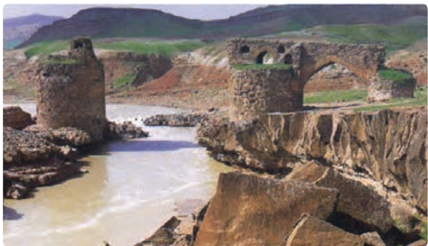
شکل ۲۹-۵- پل گاومیشان دره شهر
