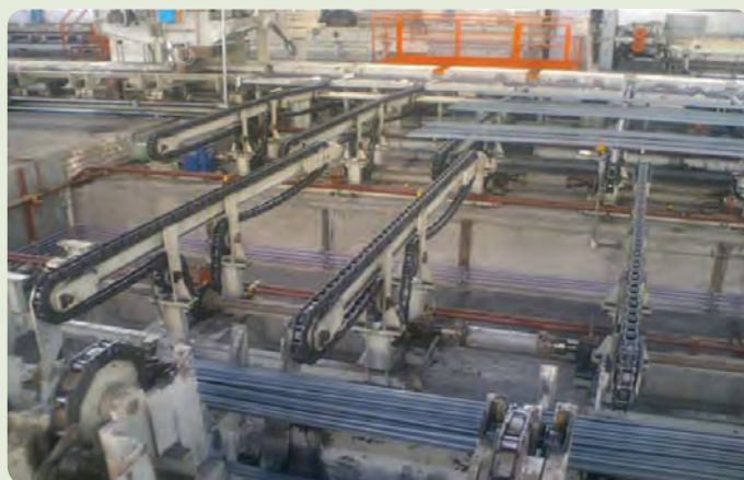
شکل ۲-۶- نمایی از کارخانه فولاد شاهرود
