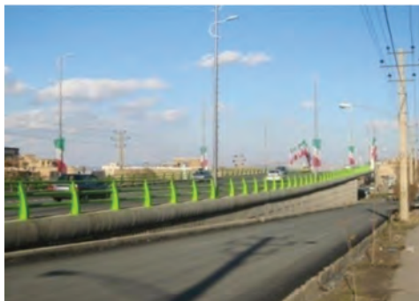
شکل ۱۰-۶- پل روگذر رسالت - همدان
