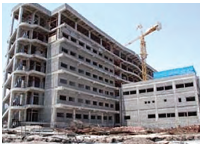
شکل ۱۰-۱۴- عملیات ساخت بیمارستان ۲۰۰ تختخوابی امام رضا(ع)
