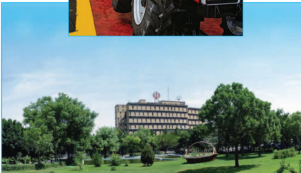
شکل ۲۹-۵- کارخانه تراکتورسازی تبریز
