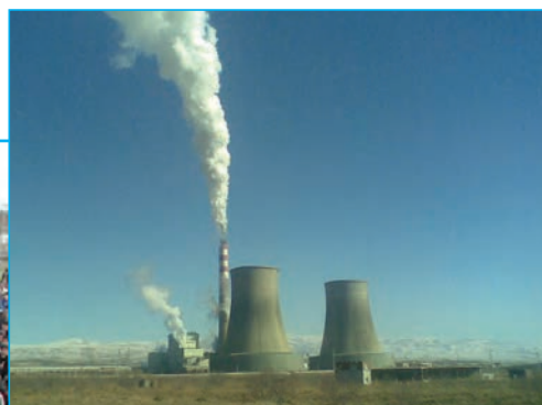
بناب- نیروگاه برق
