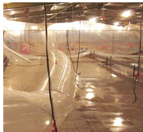
۳ کانال پلاستیکی هوای گرم در روی زمین
