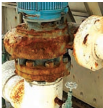
شکل ۵-۵۰- خوردگی الکتروشیمیایی قطعات فلزی
