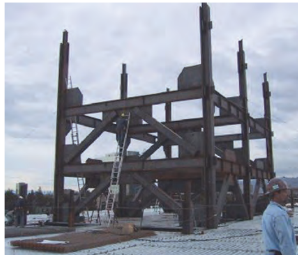
شکل ۳-۸ - تصویر یک سازه‌ی فلزی
