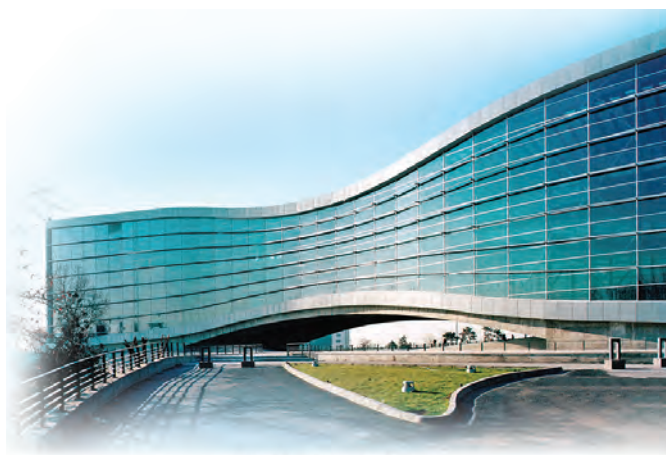
۳ - بنای ساخته شده
