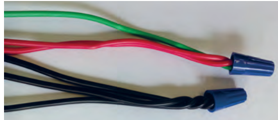
شکل ۴۳- بستن کانکتور پیچی
