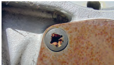
ب) استفاده ناصحیح از آچار پیچ گوشتی
