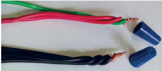
شکل ۴۴- آماده کردن سیم
