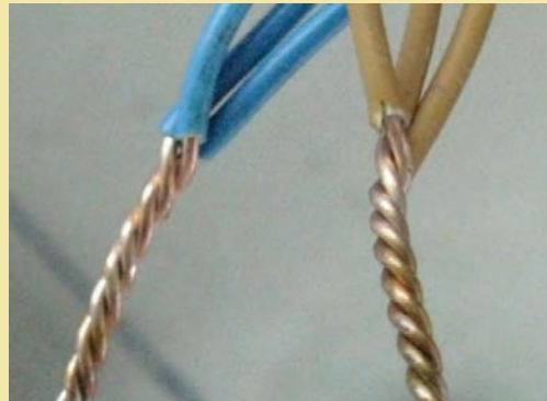
شکل ۲۳- اتصال سربه‌سر
