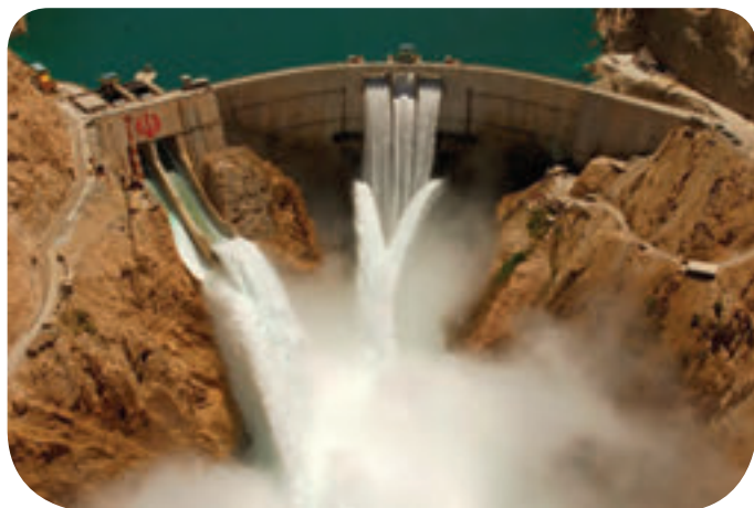
شکل ۳- سد و نیروگاه آبی کارون ۳ استان خوزستان
