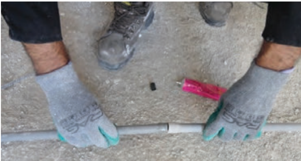
شکل ۴۸- اتصال لوله PVC
