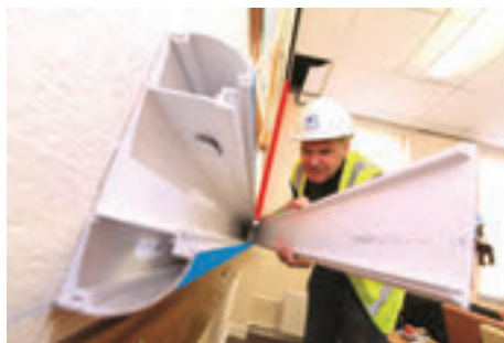
شکل ۴۳- نصب درپوش ترانکینگ
