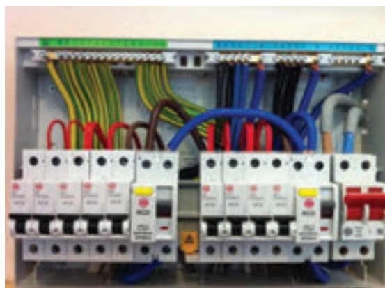
شکل ۴۹- اتمام سیم‌کشی قطعات تابلو
