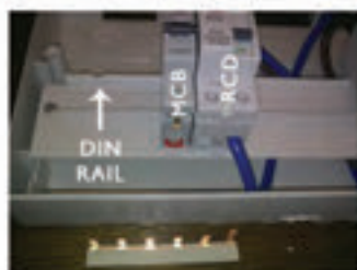
ب) قبل از نصب شین
