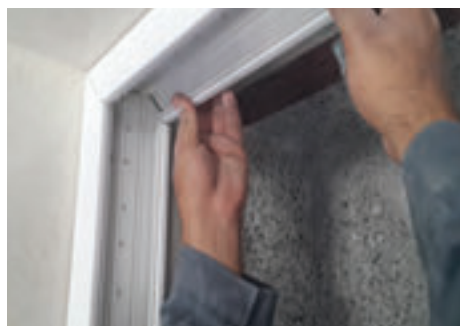
شکل ۵۰- برش و فارسی بر کردن ترانکینگ
