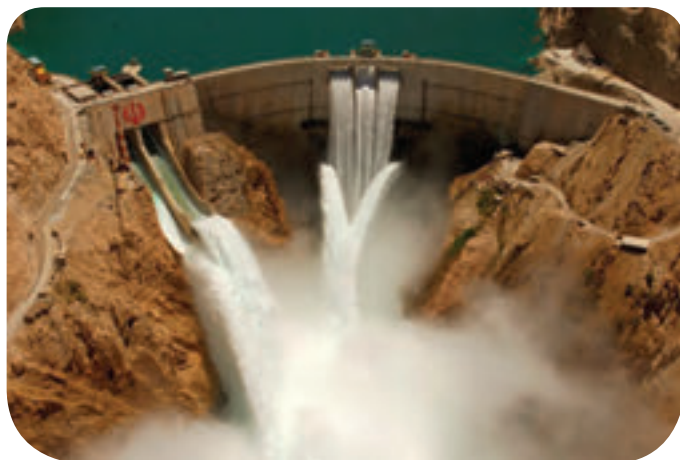
شکل ۳- سد و نیروگاه آبی کارون ۳ استان خوزستان
