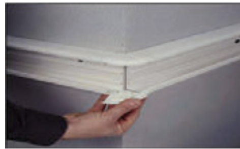
شکل ۴۴- نصب در پوش ترانکینگ زاویه دار
