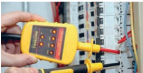
شکل ۵۴- تست تابلو با نشانگر ولتاژ
