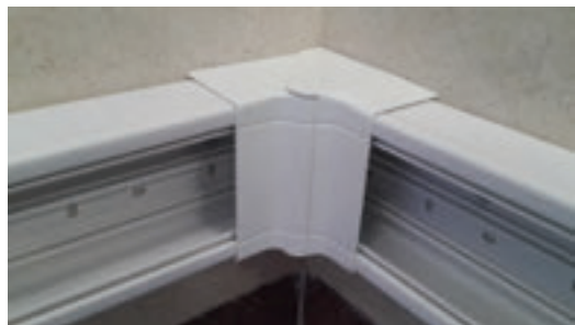
شکل ۵۱- نصب زانوی داخلی
