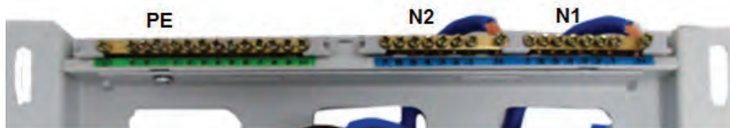
شکل ۸۰- ترمینال‌های نول و اتصال زمین
