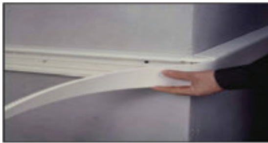
شکل ۴۴- نصب در پوش ترانکینگ زاویه دار
