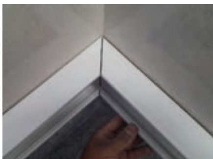
شکل ۵۰- برش و فارسی بر کردن ترانکینگ
