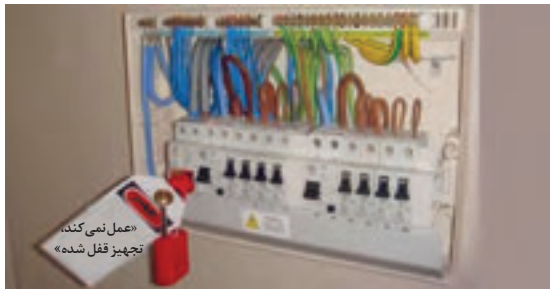
شکل ۵۳- نصب برچسب و قفل
