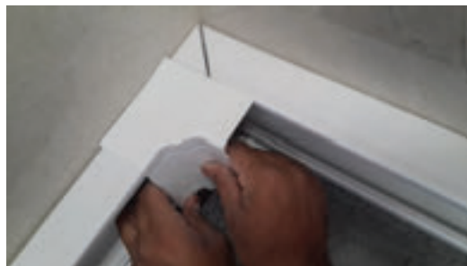
شکل ۵۱- نصب زانوی داخلی
