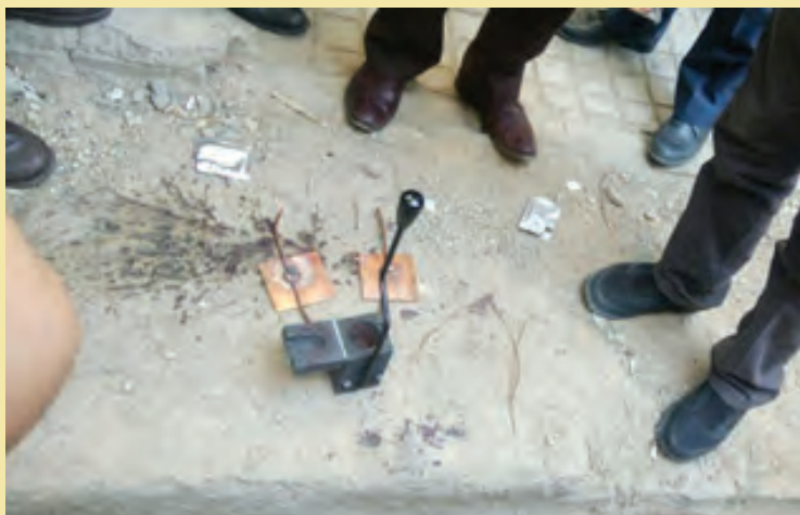
شکل ۹۸- رعایت فاصله از بوته مخصوص جوش اگزوترمیک
