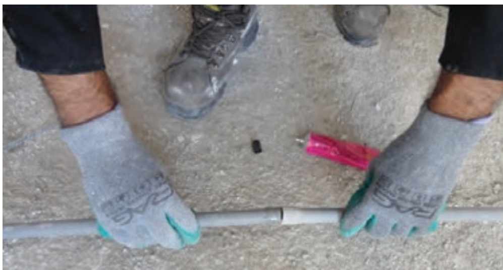
شکل ۴۸- اتصال لوله PVC
