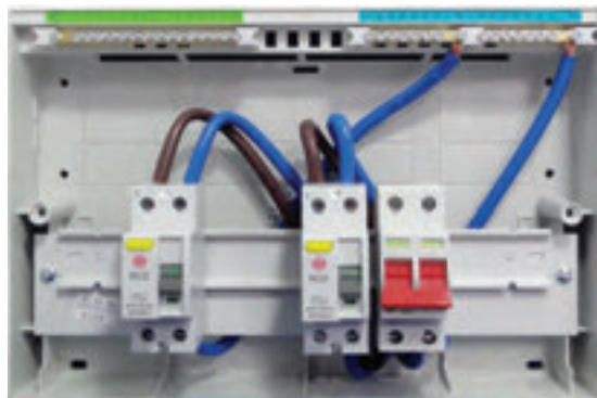
شکل ۴۷- سیم کشی قطعات تابلو
