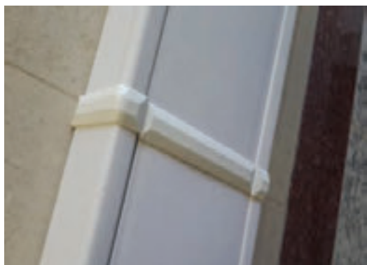
شکل ۵۳- استفاده از رابط
