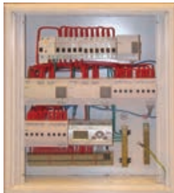
شکل ۵۳- دو نمونه تابلوی توزیع برق (DP)
