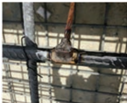
شکل ۱۱- اتصال هادی همبندی مسی به میلگردهای موجود در سازه با استفاده از جوش احتراقی
