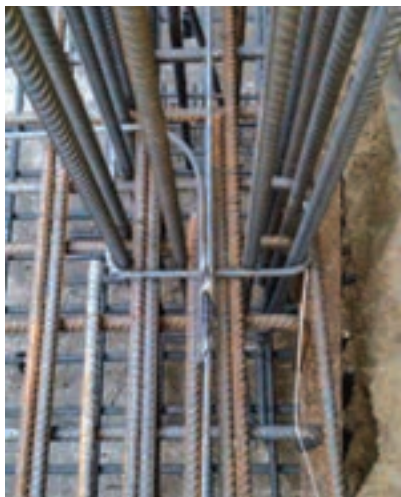
شکل ۲۲- جوشکاری میلگردهای شناژ با شالوده
