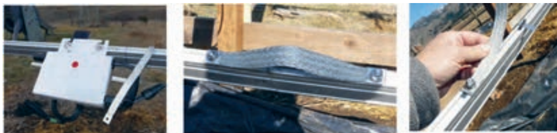
شکل ۲۹- همبندی در سامانه فتوولتاییک
