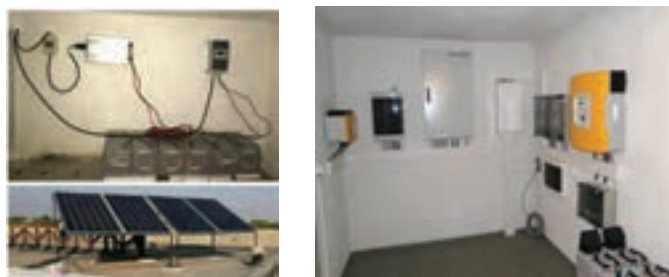
شکل ۴۶- اجرای دو نمونه سیم‌کشی سیستم فتوولتاییک
