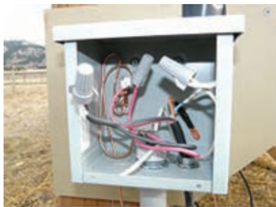
شکل ۳۵- اتصال میله مسی به بدنه تابلو اتصالات
