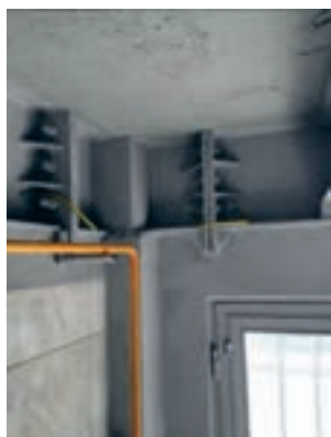
شکل ۲۴- اتصال اسکلت فلزی بیچی
