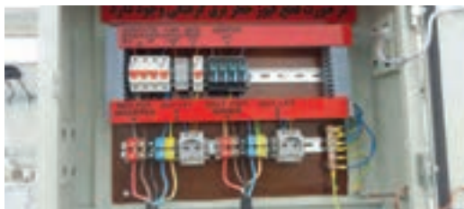
شکل ۶۴- نصب سرچ ارستر
