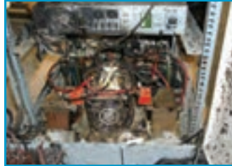
شکل ۳۴ – سوختگی در اثر صاعقه
