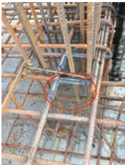
شکل ۱۹- جوشکاری میلگردها در یک تقاطع چهارراه
