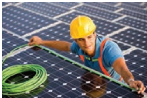
شکل ۳۰- همبندی بدنه فلزی آرایه‌ها و اینورتر
