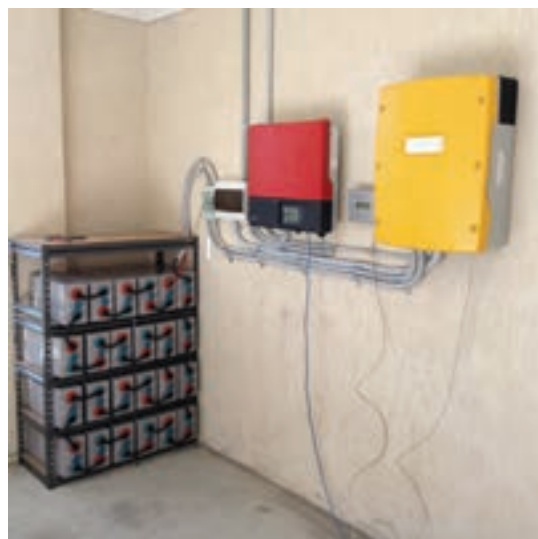
شکل ۶۱- اتصالات سیستم فتوولتائیک
