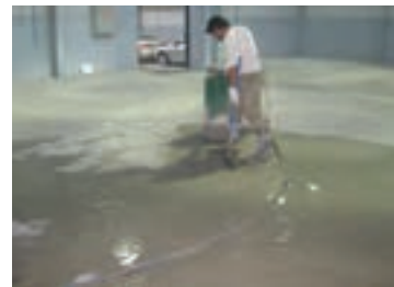
اجرای ملات برای مسطح کردن سطح
