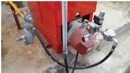
شکل ۲۹- اتصال مدار سوخت
