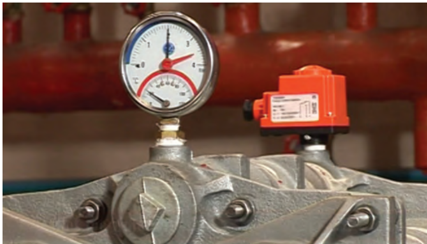
شکل ۲۱- نصب کنترل کننده و نشان دهنده دیگ
