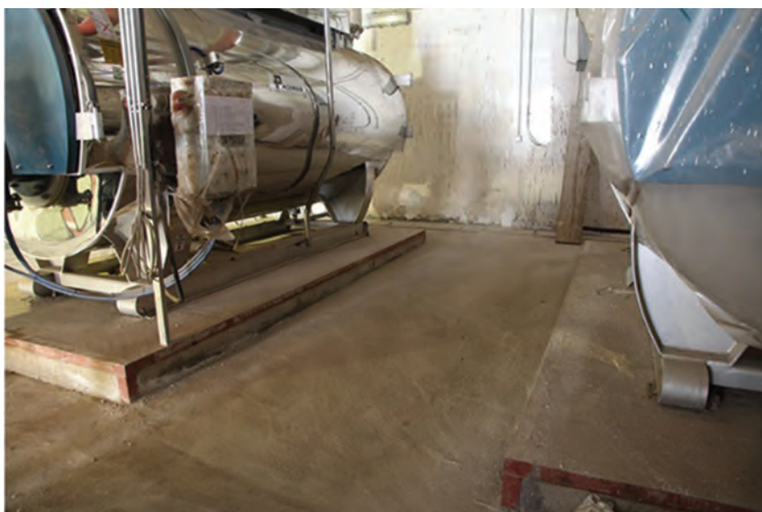
شکل ۱۴ - نصب دیگ روی فونداسیون
