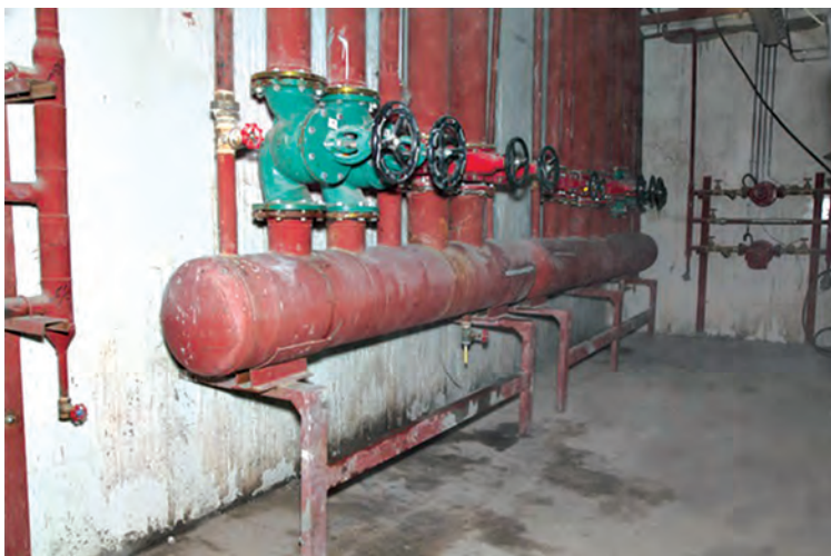
شکل ۱- نصب شیر تخلیه کلکتور
