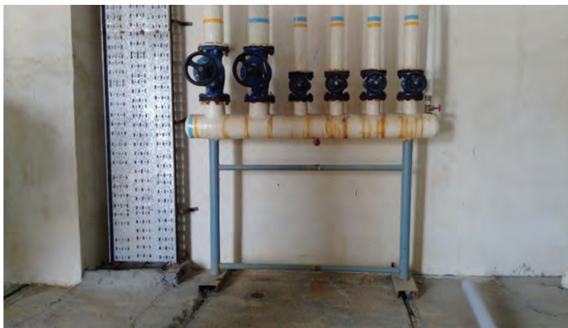
شکل ۲- نصب پایه کلکتور
