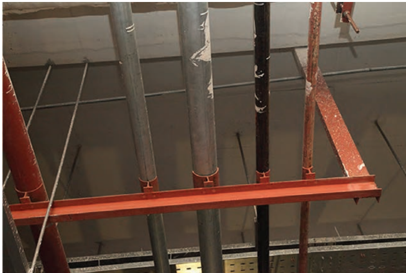
شکل ۱۶- آویز چند لوله‌ای
