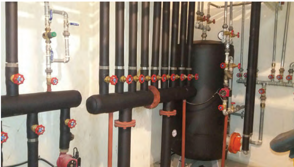
شکل ۲۵- عایق کاری در موتورخانه
