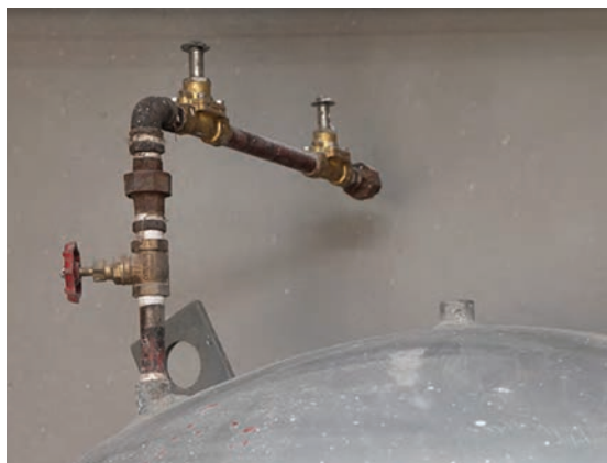
شکل ۲۳- اتصال لوله هواگیری مخزن
