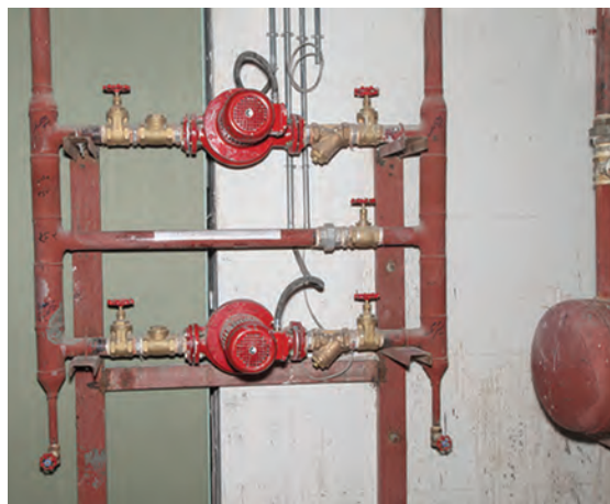
شکل ۲۴- اتصال شیر تخلیه
