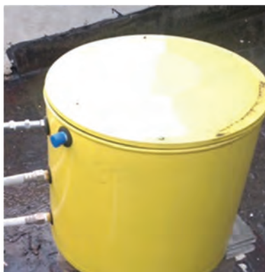
شکل ۳- مخزن انبساط باز با عایق
