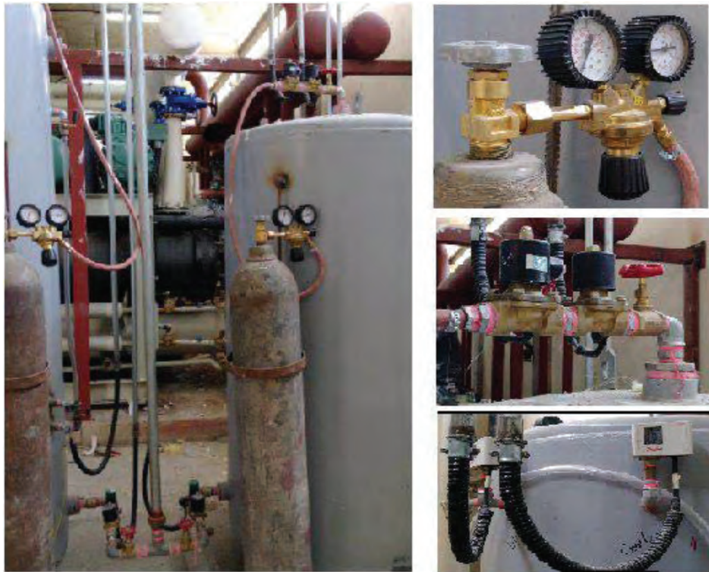
شکل ۲۳- مخزن انبساط بسته با متعلقات
