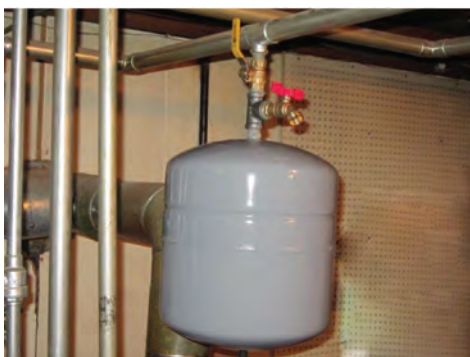
شکل ۲- مخزن انبساط بسته
