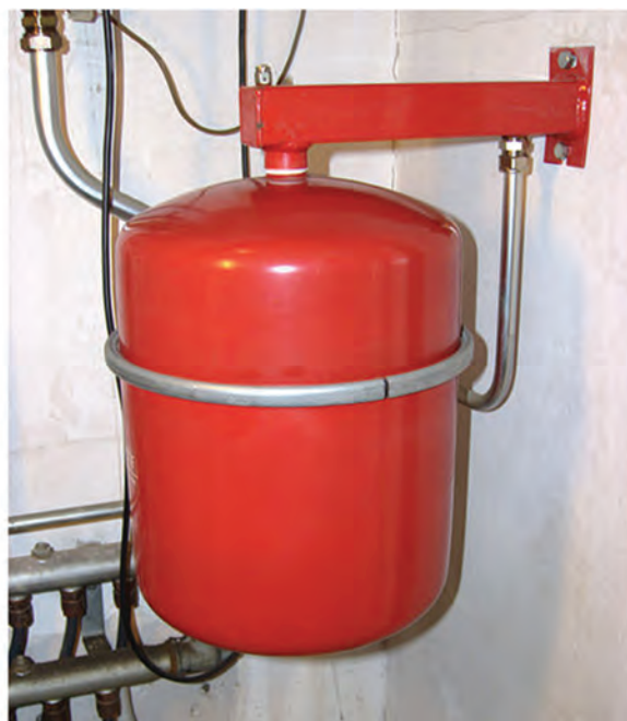
شکل ۱۶- استقرار مخزن انبساط بسته
