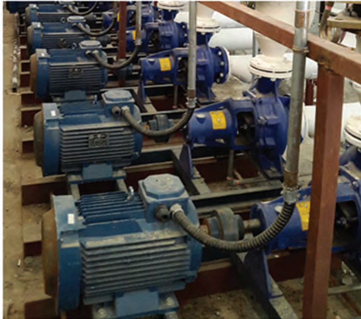
شکل ۲۴- اتصال موتورهای سه فاز
