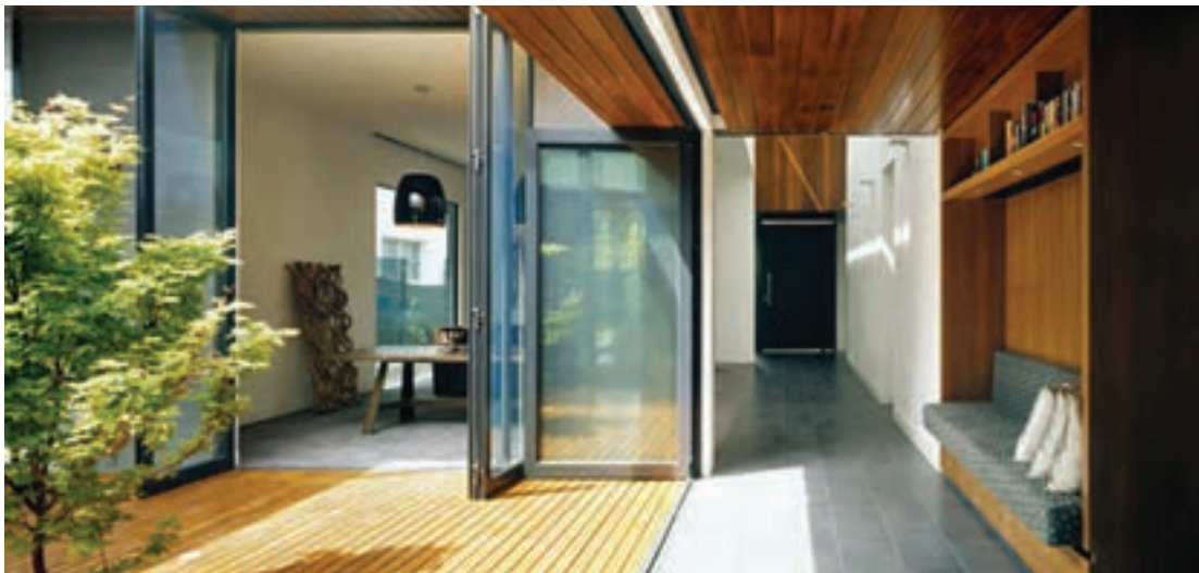
شکل ۵-۲- با گشوده شدن درهای آکاردئونی جمع‌شونده راهرو در مجاورت حیاط سبز خانه، راهرو و حیاط یکی شده و فضایی دل‌باز و زیبا برای نشستن پدید آمده است.
