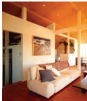
شکل ۱۱-۲- نمایانی عناصر سازه‌ای در زیر سقف و نرسیدن دیوار به آن.
