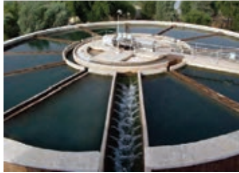
آب در تصفیه‌خانه
