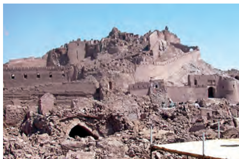
ارگ بم، بزرگ‌ترین سازه خشتی جهان در زلزله بم دچار تخریب زیاد شد.
