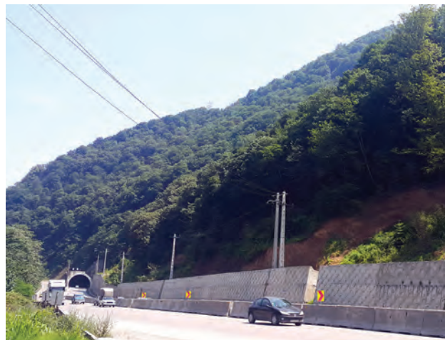
نصب حفاظ بتونی - جاده قائم‌شهر
